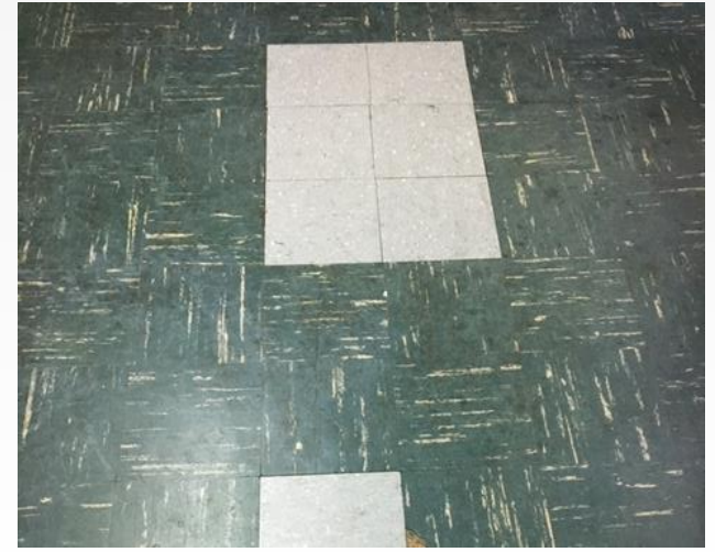
Asbestos Tiles
